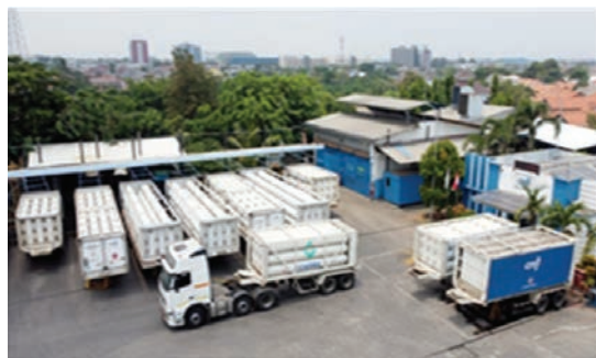
Depo Bandung Capacity 0,2 MMSCFD
