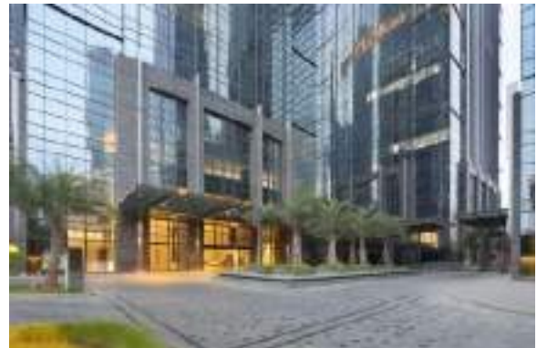
Tampak Depan Gedung Perseroan
